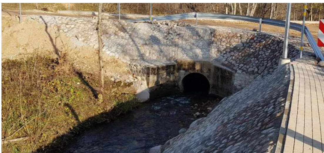
69.att. Literatūras studija. Ieteicamais apbetonējums lielajām caurtekām zem brauktuvēm (Meža parka ieejas zonās – I-1, I-2, I-3, pie Tēriņu ielas) [Avots: autora uzņemta fotogrāfija]
