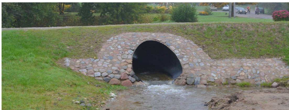
68.att. Literatūras studija. Ieteicamais apbetonējums mazajām caurtekām zem kopīgā gājēju un velosipēdu ceļa ar akmeņiem
