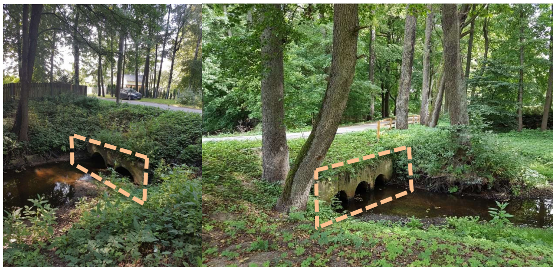
41., 42. att. Caurtekas zem Dauguļu un Codes ielas [Avots: autora uzņemtas fotogrāfijas]
